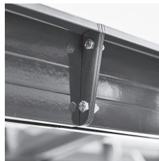
Pfettenverschraubung Edelstahl Schrauben/Muttern
